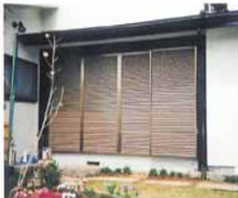
住宅の掃出し窓に雨戸新設 (東京都新宿区)
