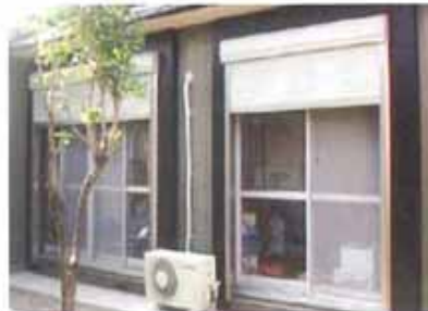
住宅の掃出し窓にシャッター新設 (名古屋市中川区)
